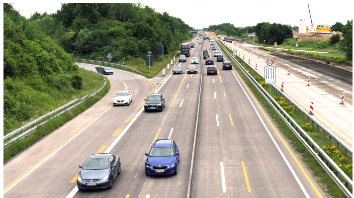
Baustelle A1 Lübeck Moisling / Foto: Jörg Schiessler/Stodo.NEWS
