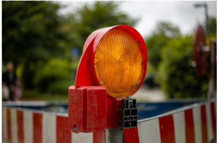
Asphaltarbeiten auf der Meierbrücke. / Foto: Jörg Schiessler/Stodo.NEWS
