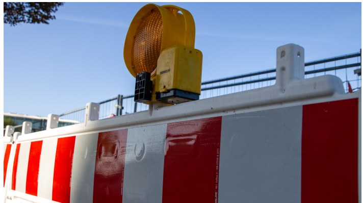
Fahrbahndeckensanierung der Straße K24, Artlenburger Straße / Foto: Inken Schmidt/Stodo.NEWS
