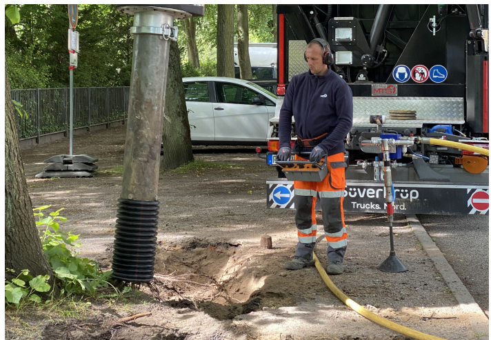
Mittels Wurzelsauger sammeln Experten Daten über den Zustand der Alleebäume und erstellen Handlungsempfehlungen. / Foto: Hansestadt Lübeck/www.luebeck.de
