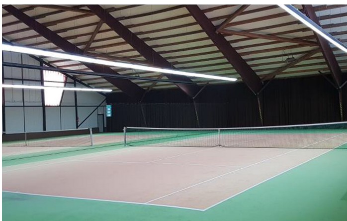
ATSV Tennishalle / Foto: ATSV Tennisabteilung
