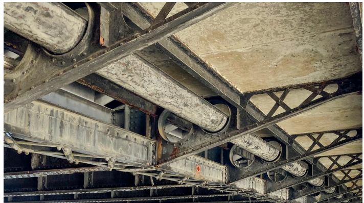
Unterbau einer Brücke. / Foto: Jörg Schiessler/Stodo.NEWS
