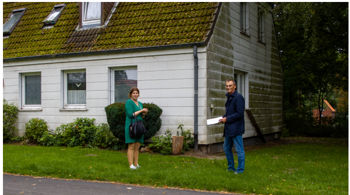
Bürgermeisterin Julia Samtleben und Bauamtsleiter Dieter Rodewald sind noch bei der Zustandserfassung der Mehrfamilienhäuser in der Dorfstraße. / Foto: Inken Schmidt/Stodo.NEWS
