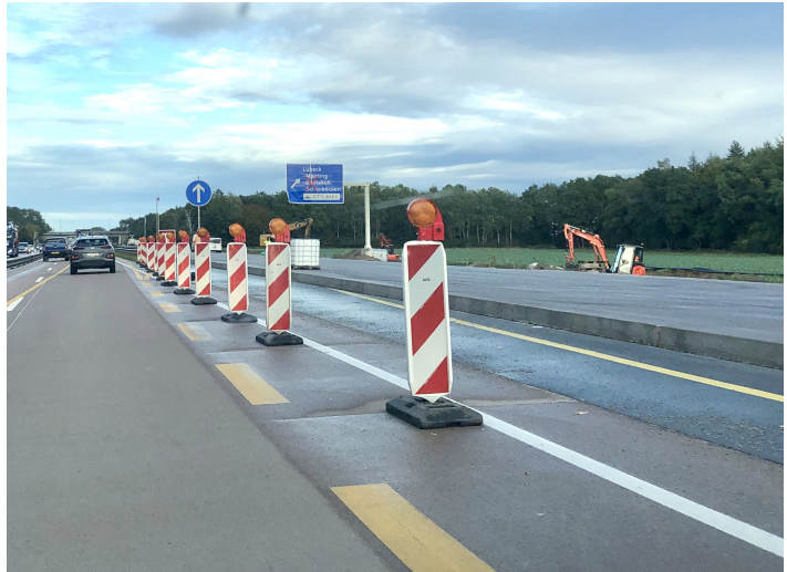
Ab dem Nachmittag des 24. Oktober wieder frei: Die Anschlussstelle Moisling in alle Richtungen. / Foto: Inken Schmidt/Stodo.NEWS
