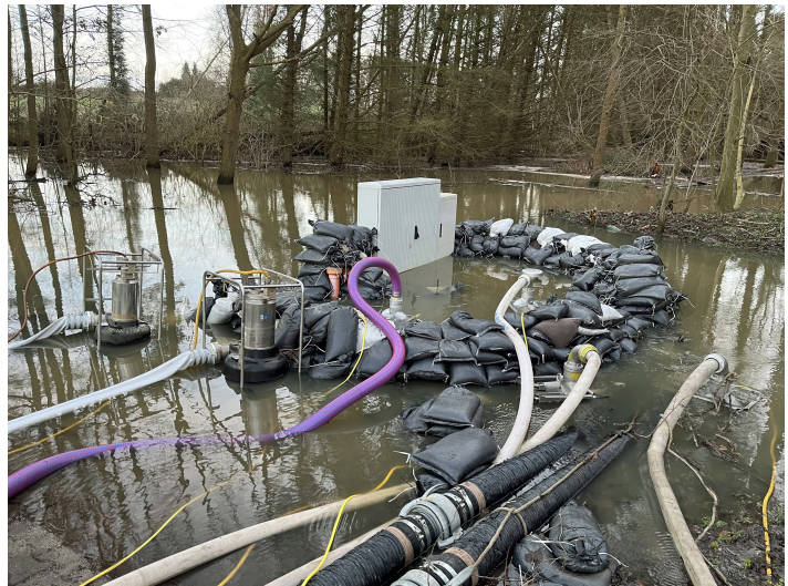
Vollgelaufene Flächen in Reinfeld. Hier wird gepumpt. / Foto: THW
