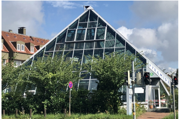
Bis vor kurzem beherbergte die gläserne Pyramide in Stockelsdorf noch ein griechisches Restaurant. Nun steht das Objekt zum Verkauf. / Foto: Inken Schmidt/Stodo.NEWS
