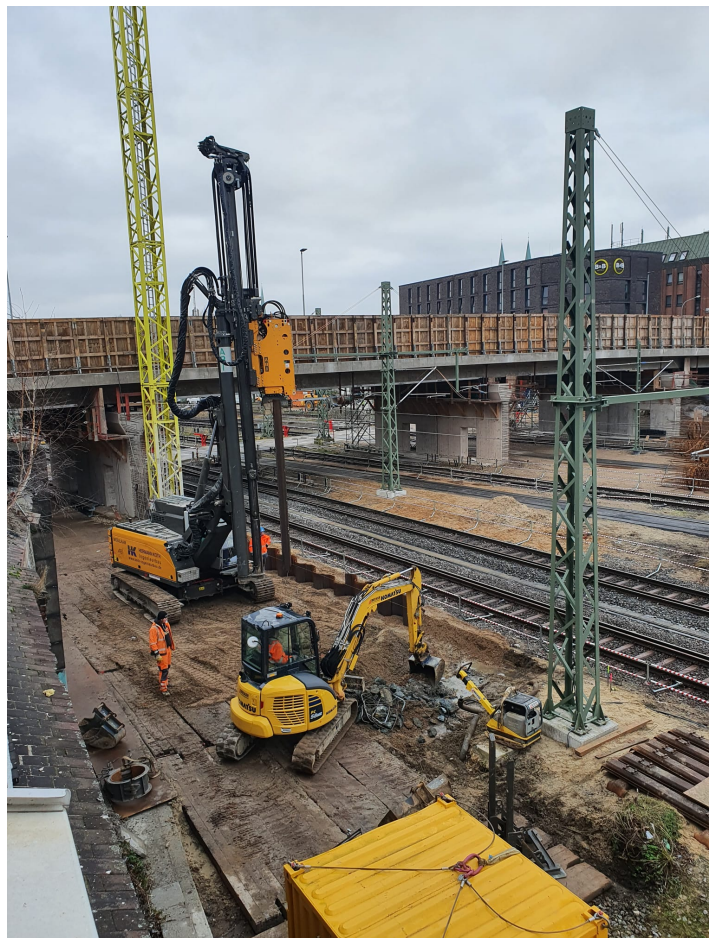
Gründungsarbeiten für das westliche Brückenteil erfolgreich abgeschlossen. / Foto: Hansestadt Lübeck/www.luebeck.de
